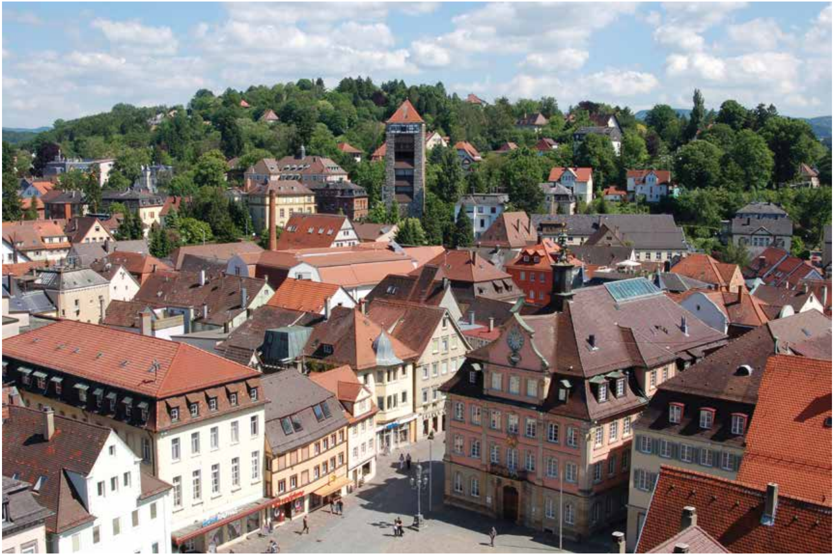
Schwäbisch Gmünd, Königsturm, Ansicht vom Johannisturm aus - Foto: Martin Eberhardt Schwäbisch Gmünd, view of the Königsturm from the Johannes Tower Schwäbisch Gmünd, vue de la tour Johannisturm sur la tour Königsturm Schwäbisch Gmünd, Torre del re, panorama dal campanile di S. Giovanni
