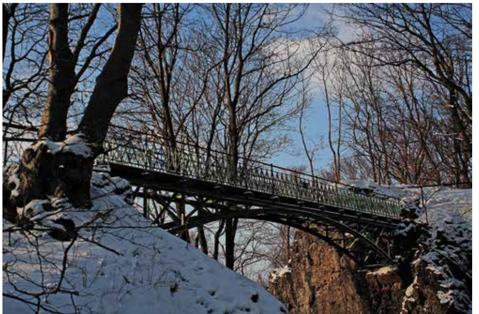
Brücke zur Ruine Rosenstein bei Heubach Foto: Joachim König Bridge at the Rosenstein ruin near Heubach Pont près de la ruine de Rosenstein près de Heubach Ponte in prossimità della rovina Rosenstein presso Heubach
