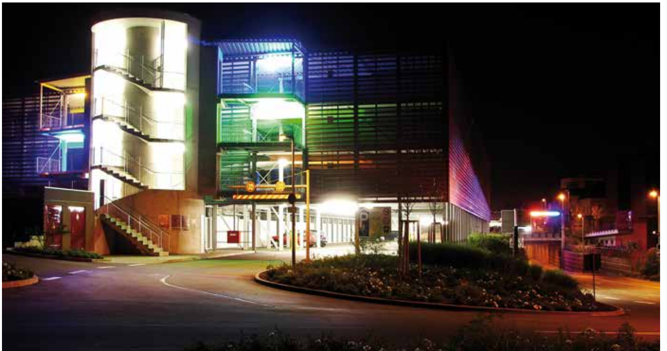
Parkhaus am Bahnhof in Aalen bei Nacht - Foto: Christian Frumolt The train station's parking garage in Aalen at night Parking à la gare d`Aalen, la nuit Parcheggio alla stazione di Aalen di notte
